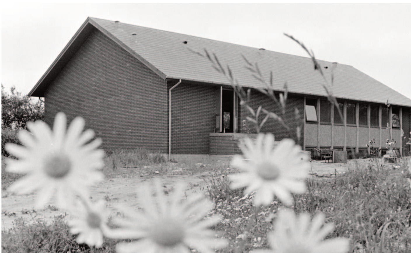
Det nye menighedshus i Sædding er ved at være færdigbygget. Villakvartererne i Sædding voksede og voksede, så for at de mange nye beboere kunne lære hinanden bedre at kende, købte kommunen en grund ved C. M. Nielsens Vej, hvor dette hus blev opført og skulle være klar til indvielse den 17. september 1966. EBA 37512-060
