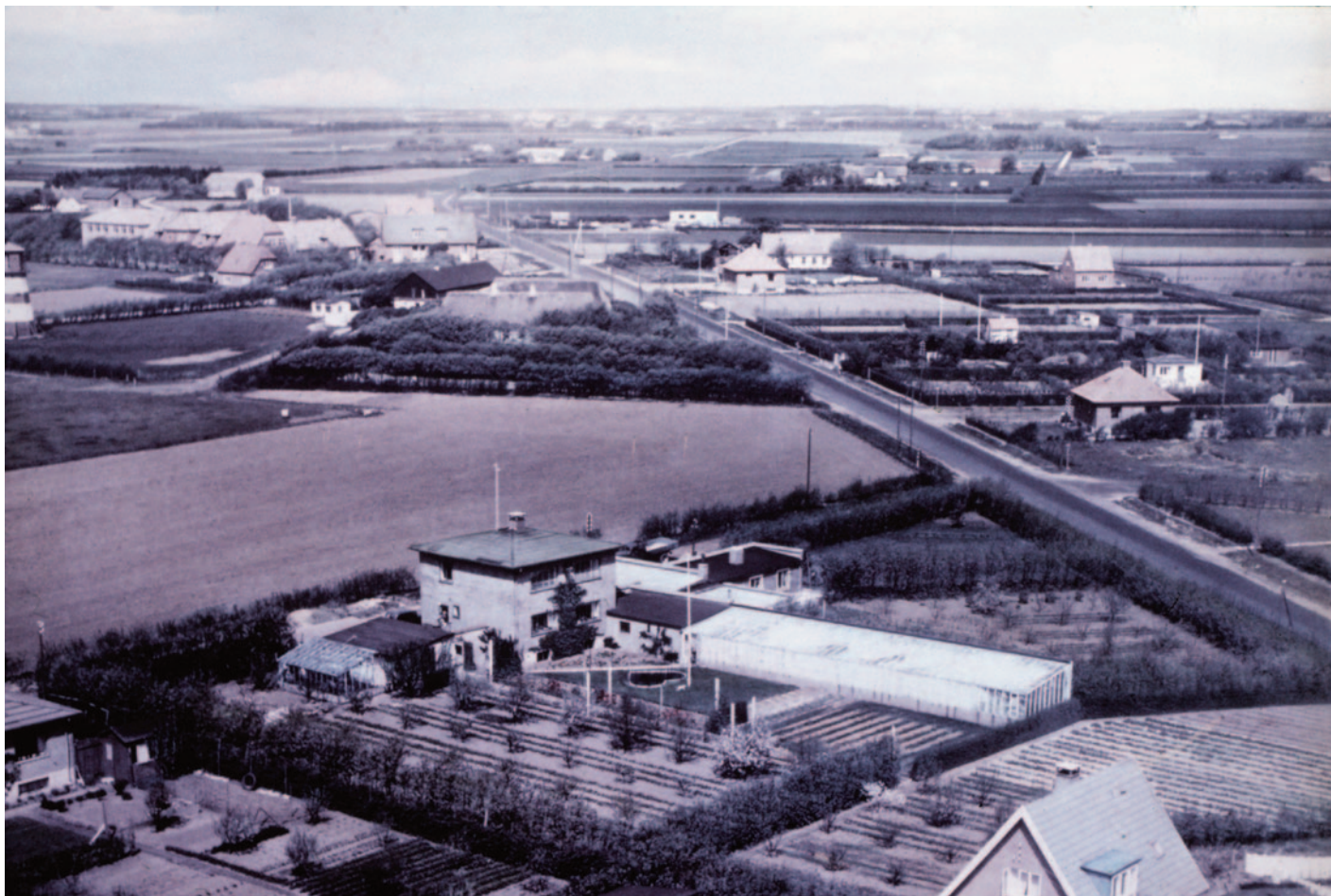
Jordstykket til Aksel Moslunds gård ses midt i billedet t.v. ud til Tarpbagevej. Her så sognerådsformand Jakob Sørensen gerne et rådhus bygget for en ny, selvstændig Guldager Kommune, men ikke en kirke. EBA 61562-070
